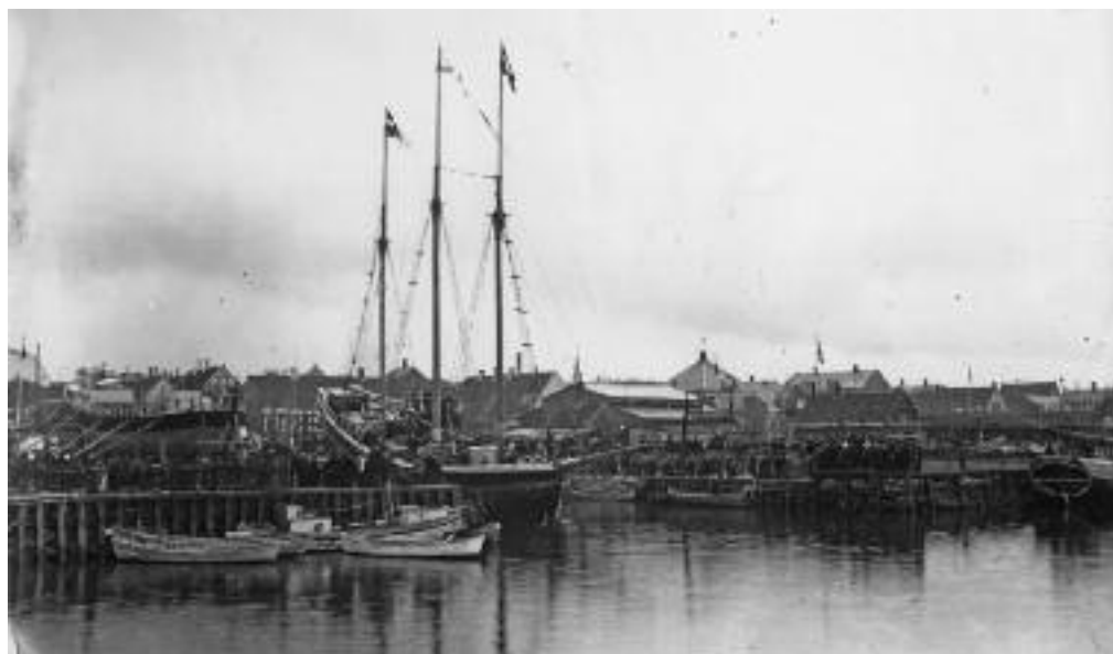
FULTON er gået i stå under stabelafløbningen. På pladsen ses en anden newfoundlands-skonnert under bygning af mester Gorm Clausen, tremastskonnert STAR. Den forsvandt sporløst allerede året efter i den barske newfoundlandsfart.
