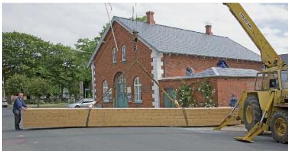
Den store svedekiste bugseres i position. Tømrer Leon Eriksen og museumsfrivillig Bjarne Christensen (med kasket) lodser svedekisten på plads. Toldbodens udhuse ses bemanded med blikkenslagere, der lægger nyt tag.
