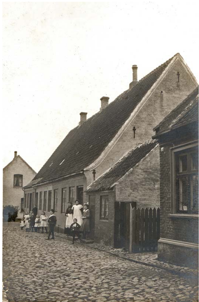
Korsgade set mod øst. I Korsgade 3 (andet hus fra venstre) blev madlavningen forstyrret, da der fløj en kugle ind ad køkkenvinduet.
