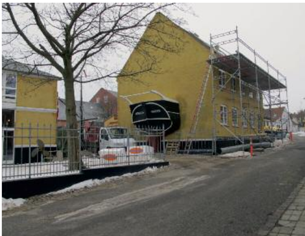
Strandstrædebygningen, udstillingbygning III, under ombygningen. Projektet er muliggjort af fornemme tilskud fra Lauritzen Fonden, SFDSs Fond, Det Dansk-Franske Dampskibsselskabs Understøttelsesfond, Augustinusfonden og millionarv efter telegrafist Keld Petersen.
